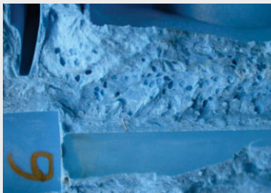
Vakuole in GF-verstärktem Bauteil
